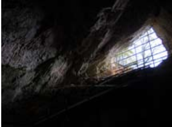
Figura 2. Entrada actual de la cueva Mendukilo. En la foto se aprecia la reja con barrotes horizontales, diseñados para el paso de los quirópteros.
