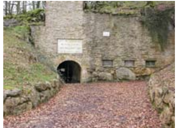
Figura 1. Muro de piedra que cerraba la entrada de la cueva Mendukilo. Se aprecia la limitación del área de intercambio entre la atmósfera de la cueva y el exterior.
